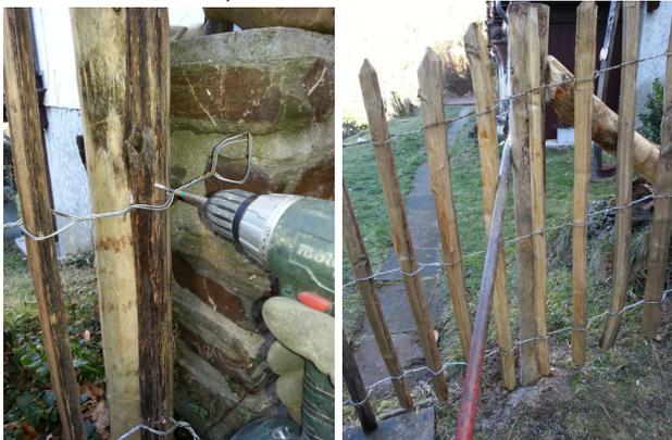
Spannen Sie mittels Brechstange den Zaun von Pfosten zu Pfosten und verschrauben ihn.
