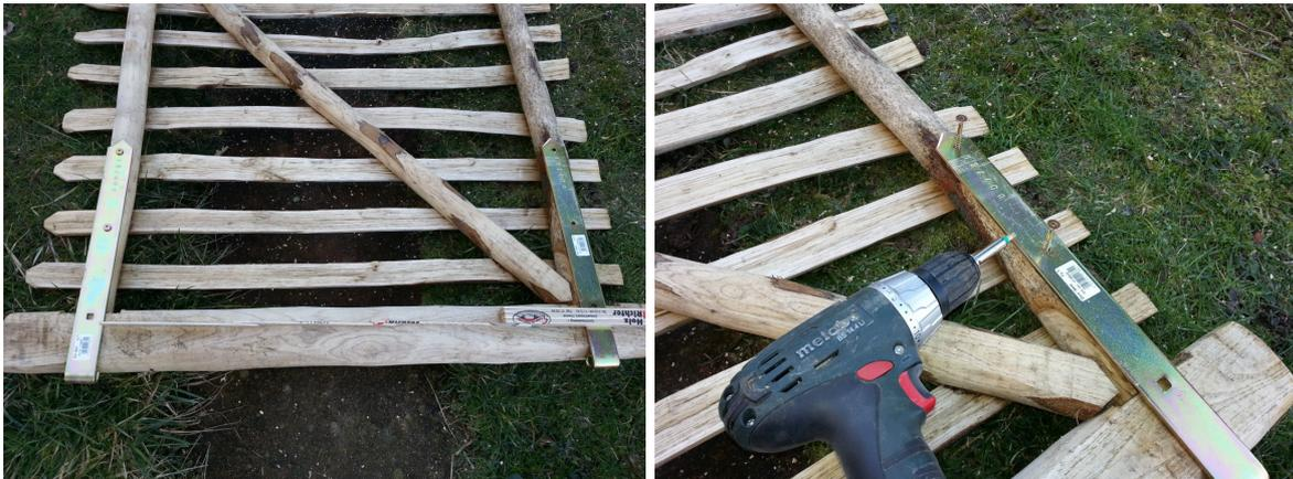
Verschrauben Sie die Ladebänder mit den beiliegenden Schrauben. Befestigen Sie die Kloben im entsprechenden Abstand an den Pfosten. Achten Sie auf lotgerechte Anbringung! Verschrauben Sie den Riegel an Tor und Pfosten...fertig!
